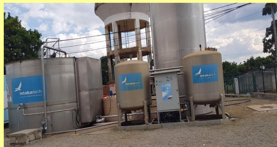
Foto acima e abaixo: estação de tratamento de água reabilitada
