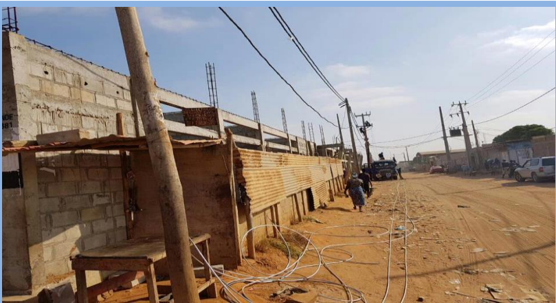
Foto acima: Posto de Transformação de Energia Eléctrica, Foto abaixo: Um dos bairros do distrito urbano da Vila Flor - Viana
