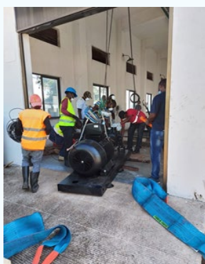
Instalação de 6 novas electrobombas na captação e elevação do SAA de Saurimo
