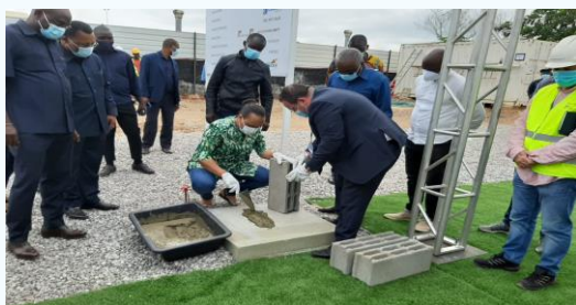
Lançamento da 1ª Pedra da construção do Laboratório de Qualidade da Água da Província do Bengo, por sua Excelência Senhora Governadora da Província do Bengo, Dr.ª. Mara Quiosa
