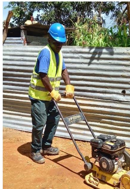
*Figura 2 - Passadeira para moradores colocada de forma aceitável (imagem à esquerda), e trabalhador operadondo compactadora sem protectores auriculares (imagem à direita), numa frente de obra em Kuito*
