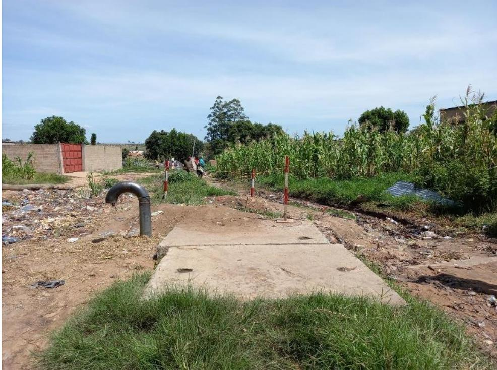
*Figura 1 - Sinalização inadequada numa das frentes de obra em Kuito, colocando peões em risco*
