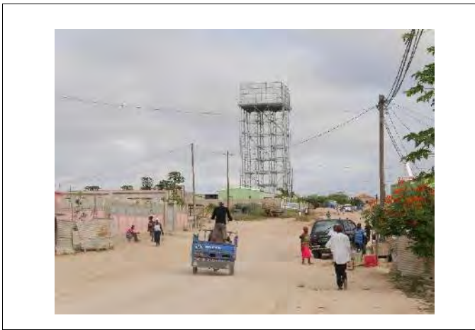
Foto50 | Reservatório RZ5 (Bairro de Pedra 2 sul)
