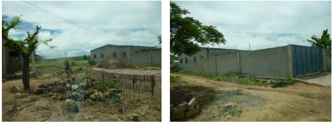
Fotografia 18 – Área não servida por abastecimento de água
