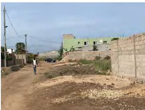
Foto 10 | Ruas com fornecimento de energia eléctrica
