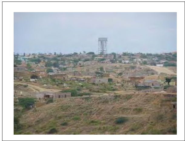
Foto 51 | Vista geral da zona RZ5
