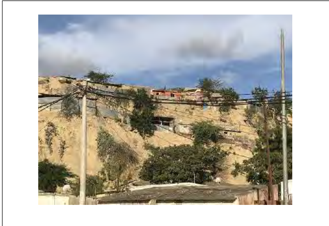
Foto 30 | Zona com risco de erosão (declive acentuado)
