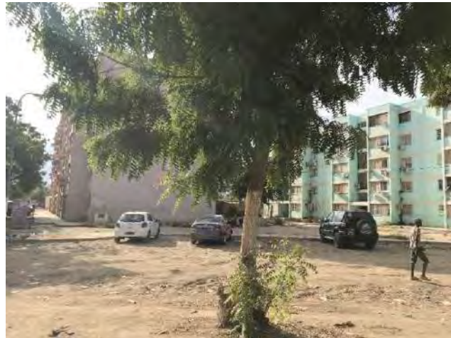
Fotografia 4 – Entrada da zona E15
