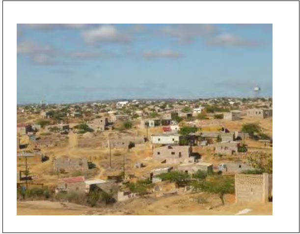
Foto 49 | Vista no alinhamento do R4 (visualiza-se também o R5 elevado)
