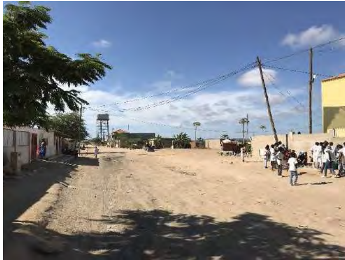
Fotografia 9 – Vista geral para o reservatório R5
