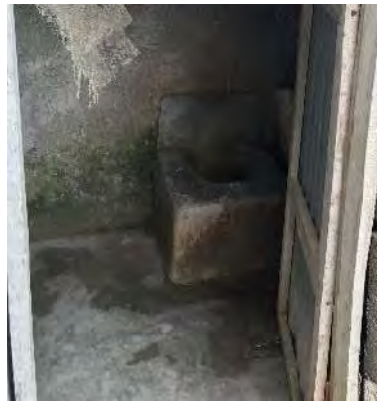
Foto 63 | Latrina de uma das casas
