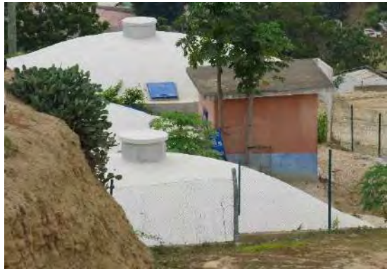
Foto 19 | Reservatório RZ3 (Bairro da cidade)
