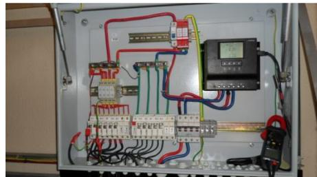
Fig. 5. Barramento DC e conversor (ou regulador) DC-DC.
