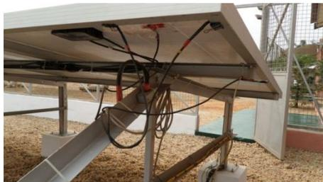
Fig. 9. Sensores de temperatura.
