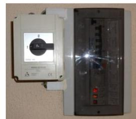
Fig. 6. Comutador Rede/Solar de alimentação da Casa-Laboratório.
