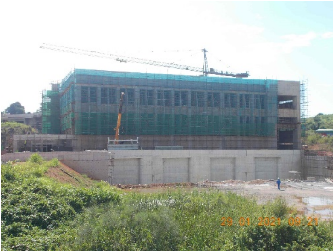
Vista exterior (jusante)
