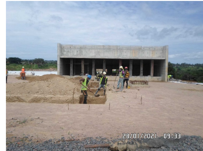
Edifício de Comando
