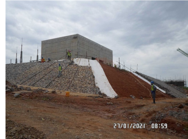
Protecção de taludes
