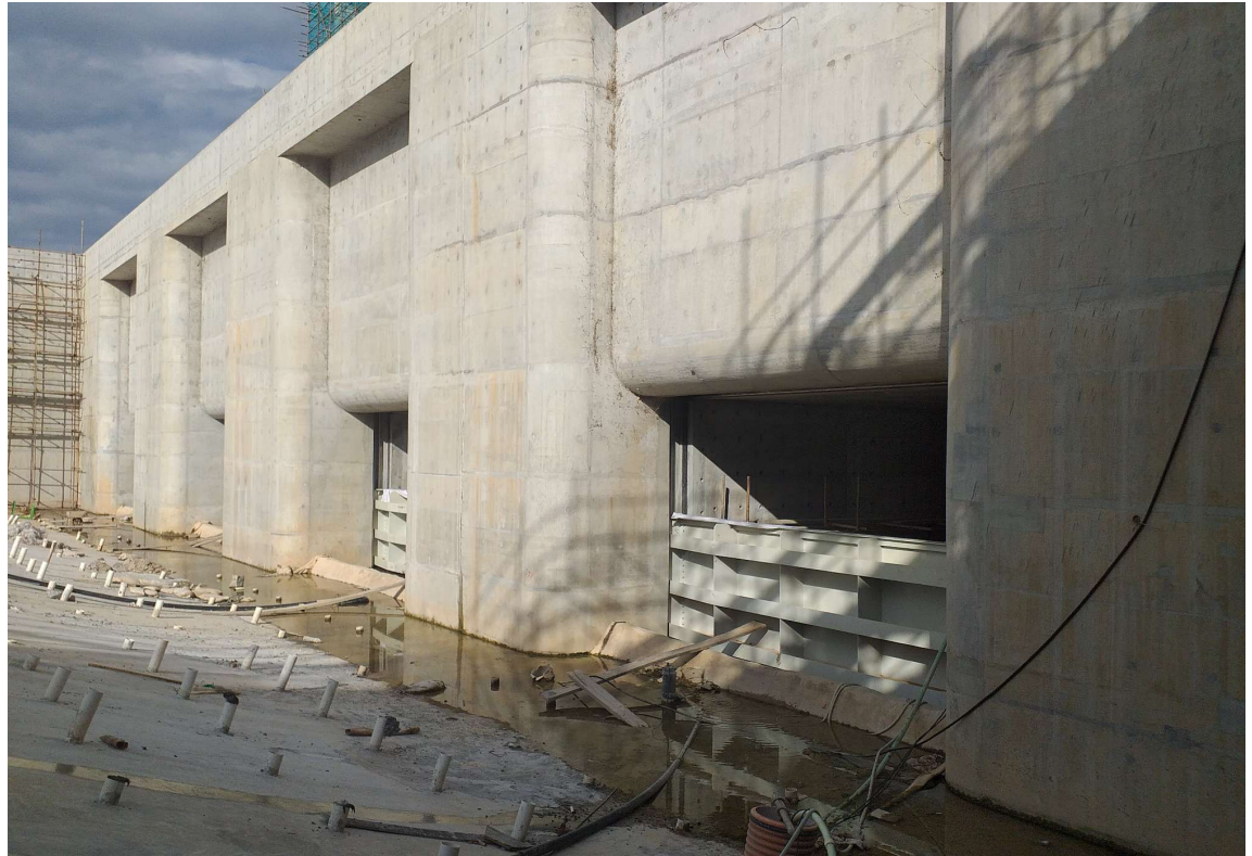
Vista para os difusores (saída de água)
