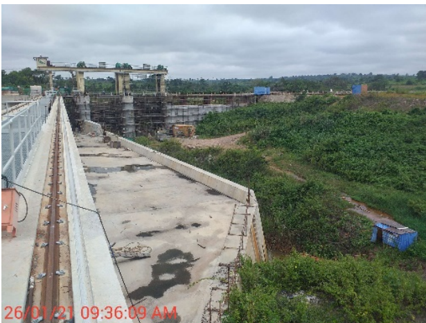
PARAMENTO DA BARRAGEM 37%
