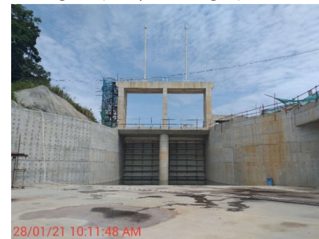
Vista geral (comportas vagão)
