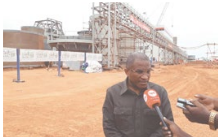
Secretário de Estado da Energia, satisfeito com os Avanços nas Obras da Central do Ciclo Combinado do Soyo
