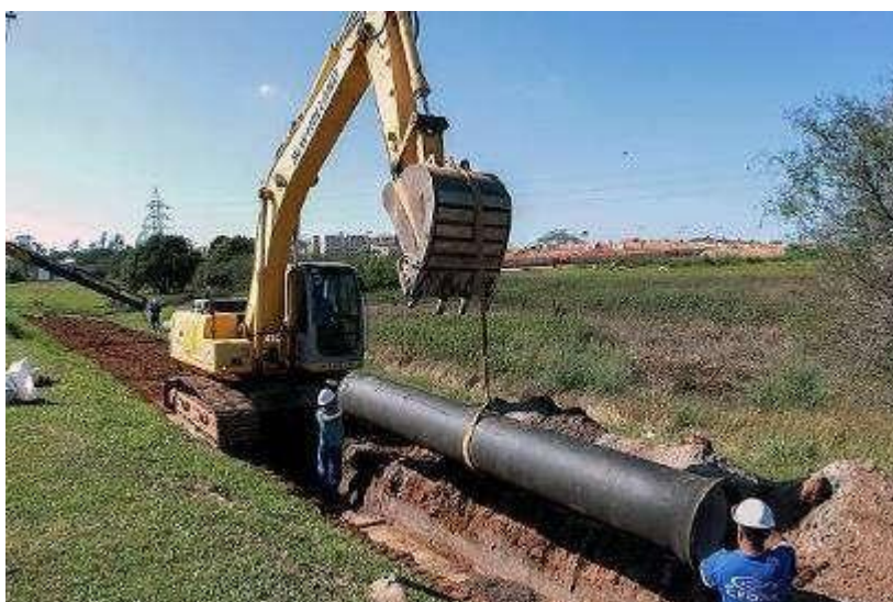
Figura 23 – Instalação de tubagem em Ferro Fundido Dúctil
