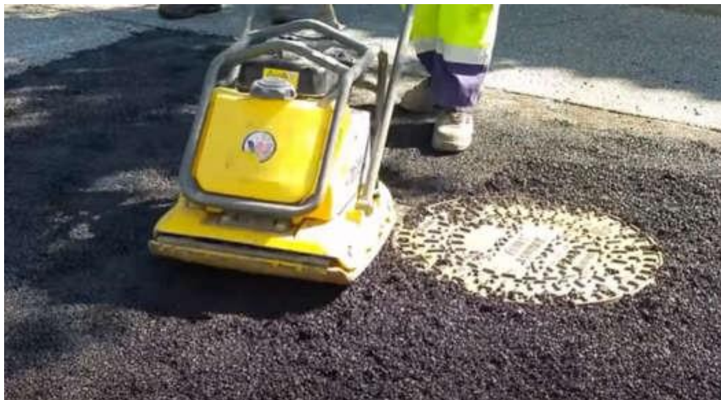
Figura 21 – Compactação da camada betuminosa
