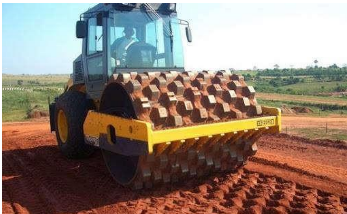
Figura 14 – Operação de Compactação com cilindro
