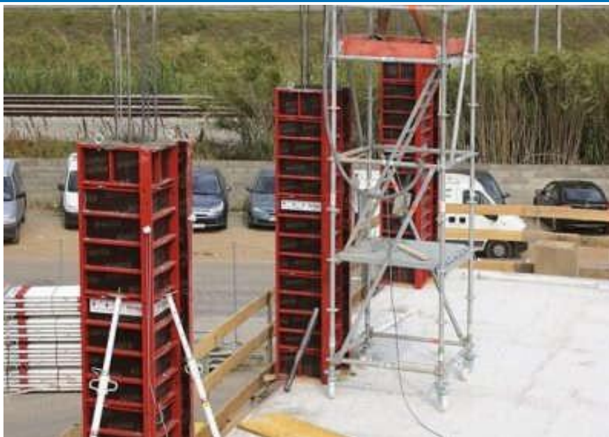
Figura 17 – Sistema de cofragem para pilares
