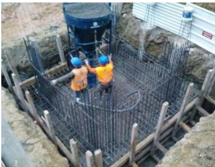
Figura 16 - Betonagem de sapata
