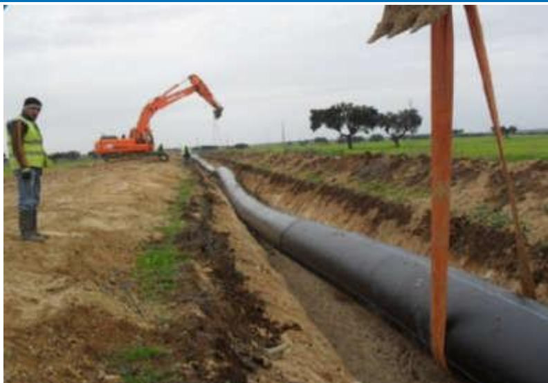
Figura 22 – Instalação de tubagem em PEAD
