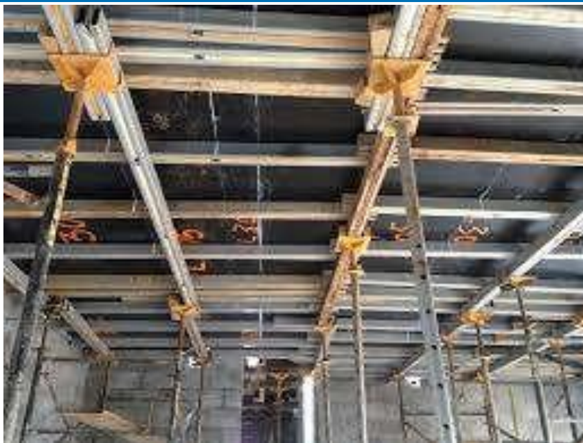
Figura 19 – Sistema de cofragem para lajes
