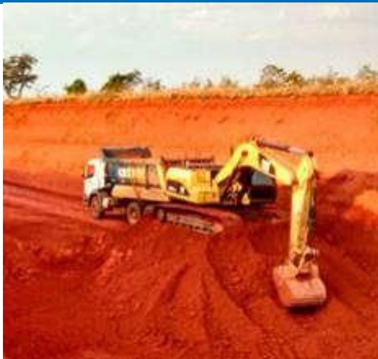
Figura 13 – Operação de escavação e carga
