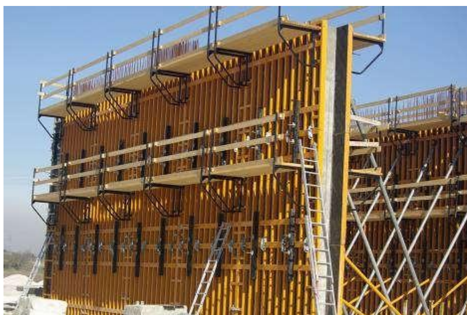
Figura 18 – Sistema de cofragem para paredes
