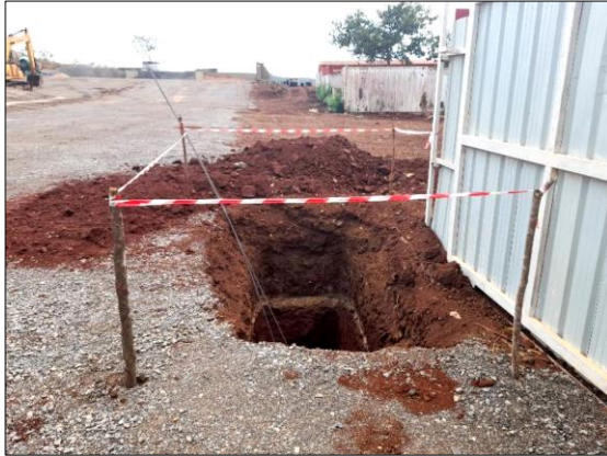
Figura 5. Protecção/isolamento inadequado numa das frentes de obra do subprojecto 8W3A em NDalatando
