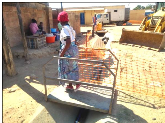
Figura 4. Passadeira para os moradores vs protecção da retroscavadora, numa das frentes de obra do subprojecto 3W3 em Huambo
