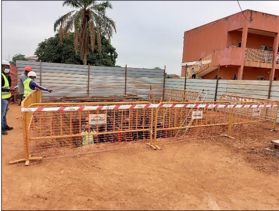
Figura 1. Área de trabalho devidamente isolada numa das frentes de obra em Uíge (5W3)
