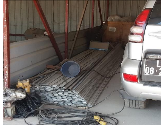
Figura 2. Gestão inadequada do estaleiro do subprojecto em Huambo (33W3-b) - estacionamento de viatura e armazenamento de material no mesmo local
