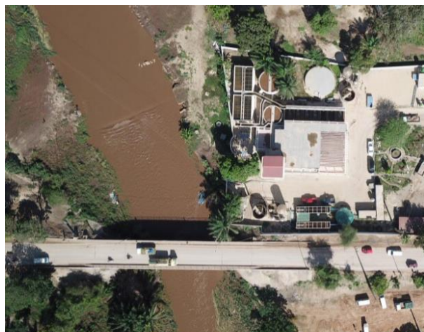
Figura 2 – Captação e ETA do Sumbe, co-financiado pelo BAD
