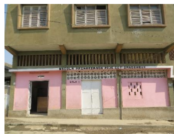
Figura 7.73 – Vista geral da escola primária Dangereux BG 2236 (bairro São João, Lobito)
