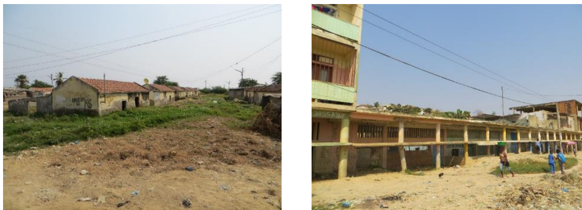
Figura 7.132 – Assoreamento junto aos Edifícios no Bairro de São João
