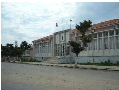
Figura 7.139 – Edifício da Administração Municipal do Lobito
