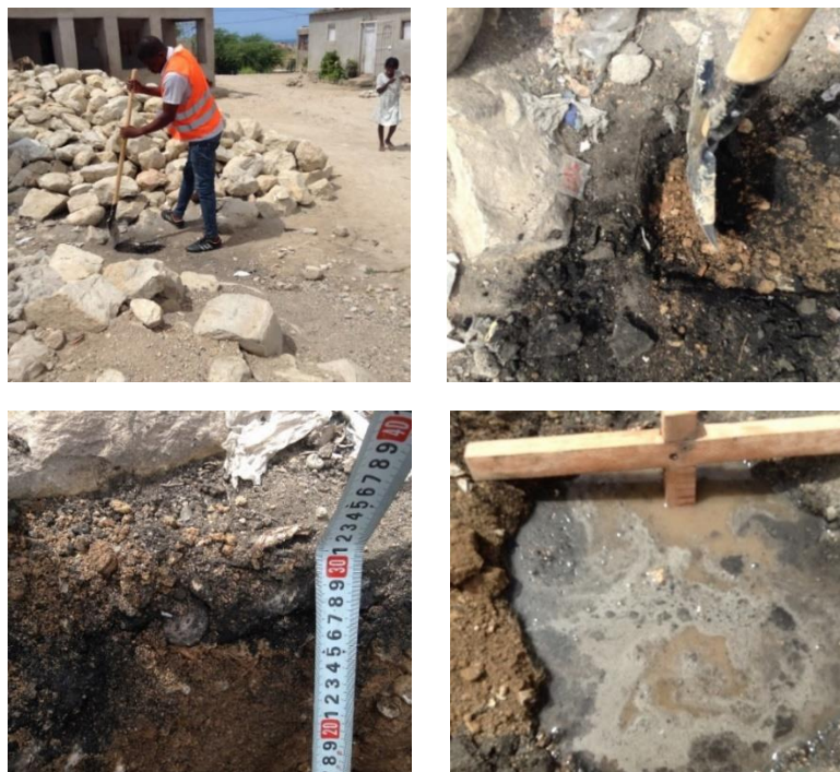
Figura 7.15 – Testes realizados no Bairro da Pomba (ID 6)
