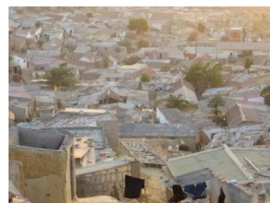
Figura 7.59 – Vista geral dos assentamentos no bairro da Bela Vista (vista 2)
