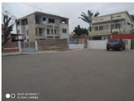
Figura 7.35 – Residência no Bairro Benfica
