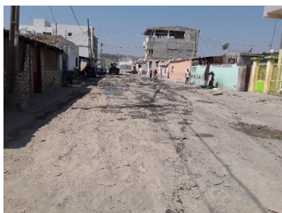
Figura 7.60 – Vista geral de arruamento no bairro da Canata
