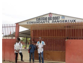
Figura 7.77 – Vista geral do Colégio Cdte. Dangereux (bairro Vila da Catumbela)
