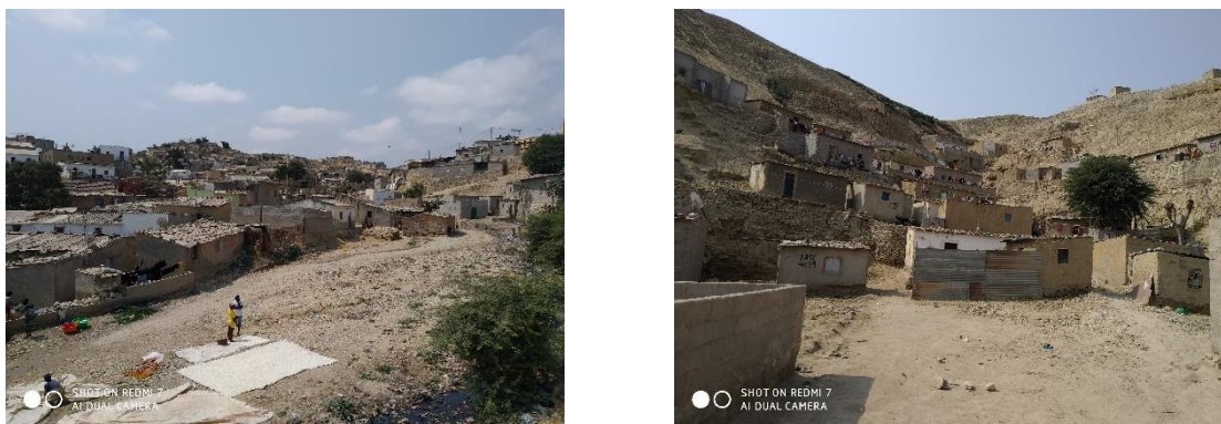
Figura 7.25 – Residências na Zona Peri-Urbana
