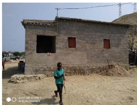
Figura 7.65 – Vista geral de assentamentos no bairro dos Coqueiros, Catumbela (vista 2)
