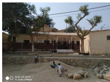
Figura 7.76 – Vista geral da escola primária Ferraz Bomboco (bairro Chiule, Catumbela)
