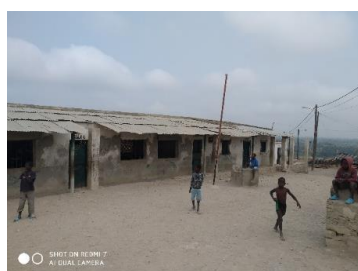
Figura 7.74 – Vista geral da escola primária Simione Mucune (bairro Chimbuila, Catumbela)
