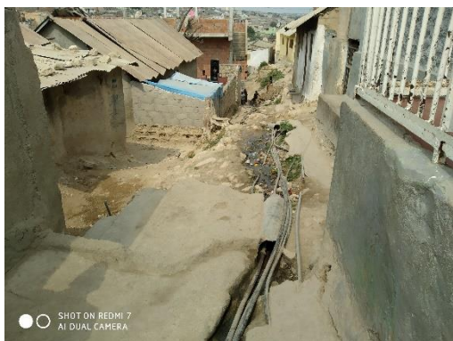
Figura 7.33 – Rua estreita no Bairro Vista Alegre
