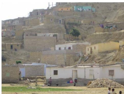
Figura 7.64 – Vista geral de assentamentos no bairro dos Coqueiros, Catumbela (vista 1)
