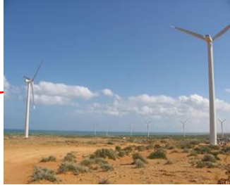
P.E. LADO ESTE (6.8 MW)
