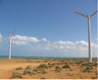
P.E. LADO OESTE (17.0 MW)
