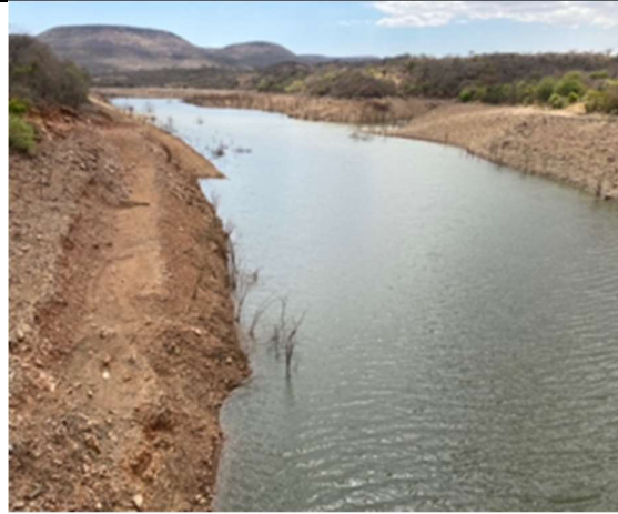
Figura 5: Visita a Barragem de Ganguelas no Municípios de Chibia
