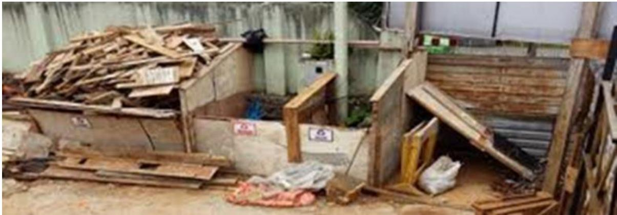
Figura 6-3: Exemplo de armazenamento temporário de resíduos de construção
