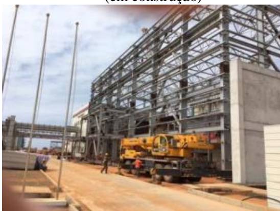
O edifício da turbina a vapor
