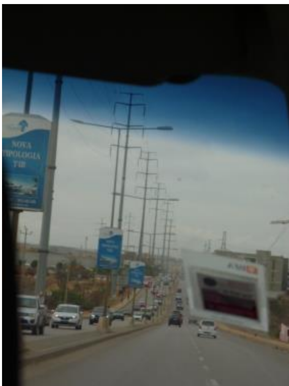
Figura 7-11 Linha de transmissão de 220 kV ao longo da estrada
