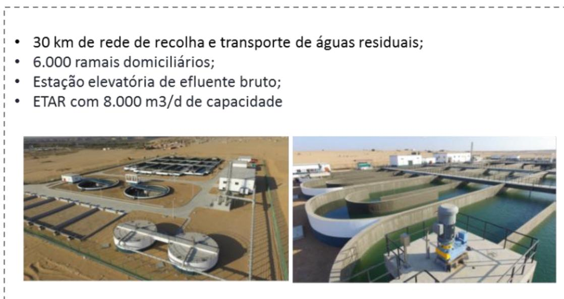
Figura 3.5: Infra-estruturas de águas residuais. ETAR de Moçâmedes – Namibe.
